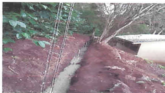
Foto 2: reparacion de muro perimetral
