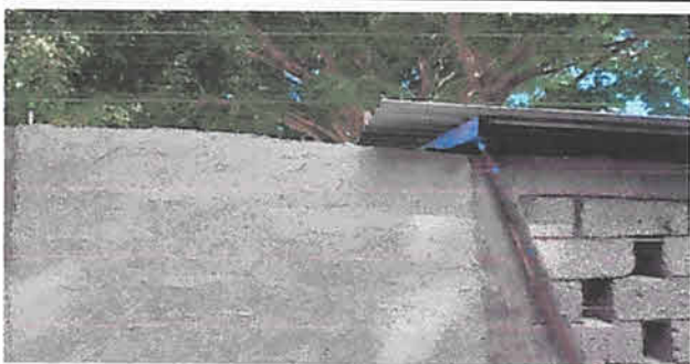
Foto 5: repello y cernido de muro de cocina
