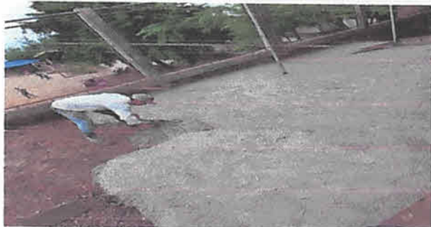
Foto 1: reparacion de losa de piso
