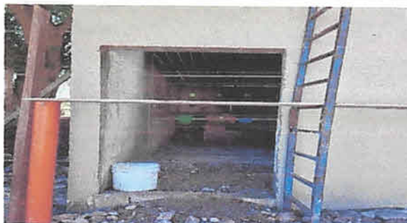
Foto 4: sustitucion de puerta de metal para cocina
