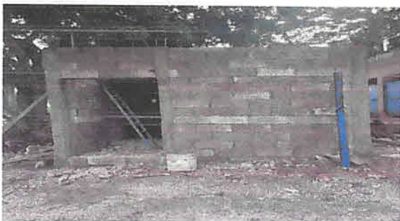
Foto 3: remozamiento de muro de block de cocina,
